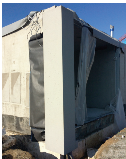
Univerzita Palackého v Olomouci - kotvení fasády s lezeckou stěnou.
