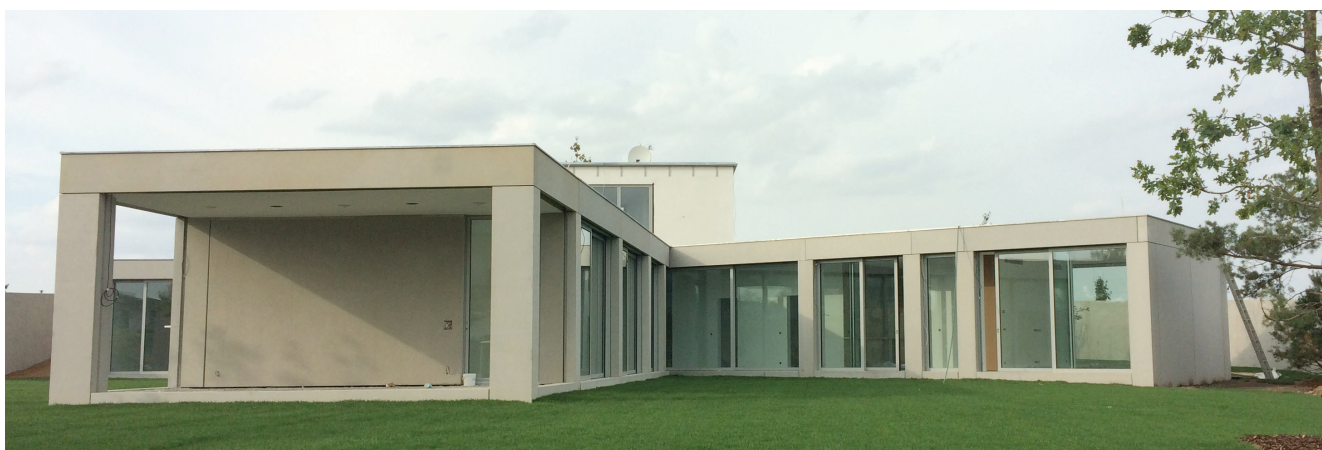
RD Zdiměřice - kotvení atypických panelů.
